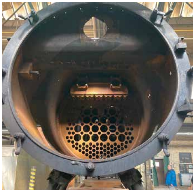
Ein Blick in den Kessel. Die Heiz- und Dampfrohre sind bereits ausgebaut.
