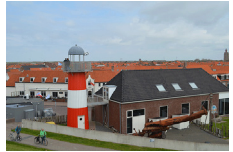
Leuchtturm – hinter dem Deich!
